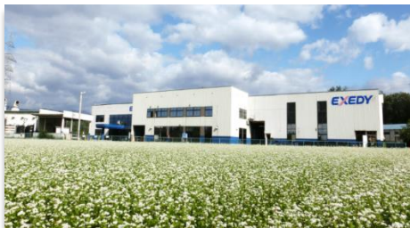
本社・松原工場
